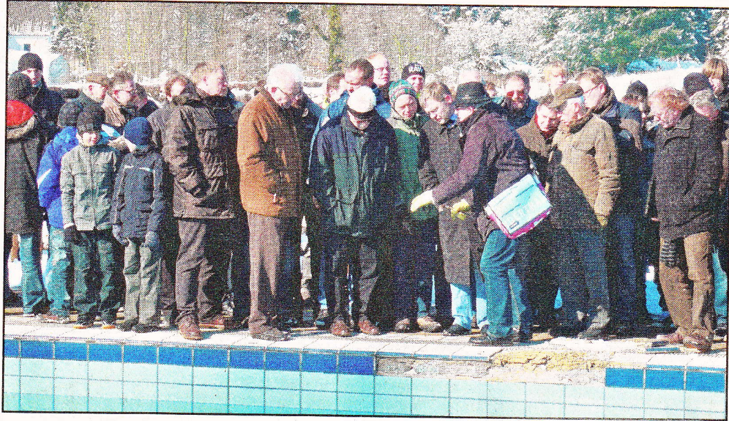
Dicht an dicht am Beckenrand: Beim Ortstermin am Samstag wurde der Zustand der Befliesung eingehend geprüft. Foto: Vehrkamp
